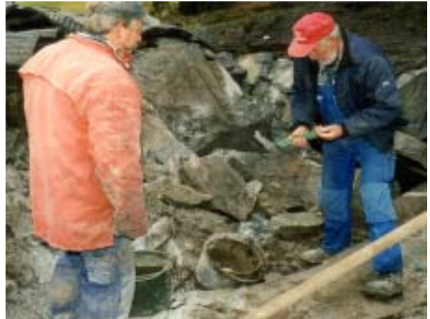
Rune strömgren övervakar laddningsarbetet före sprängning
